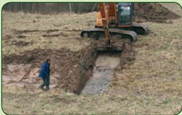
Prieš kasdami vandens telkinį pirmiausia nustatykite, kaip giliai slūgsio molingasis sluoksnis ir stenkitės jo nepažeisti
